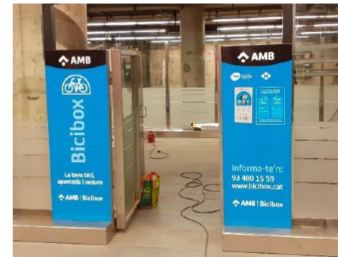
(3) Aparcament en vestíbul d'estació de metro. Parc Logístic de la línia L9 de metro
