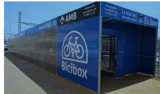
(1) Aparcament de gran capacitat. Estació RENFE Rodalies de Gavà
